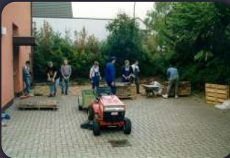
Beginn der Arbeiten für den Gerätehausanbau im Oktober 1993
