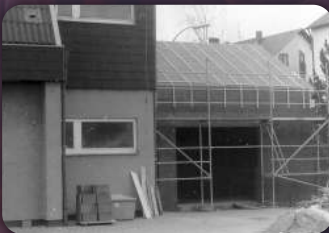
Der Rohbau steht und die Innenarbeiten beginnen.
